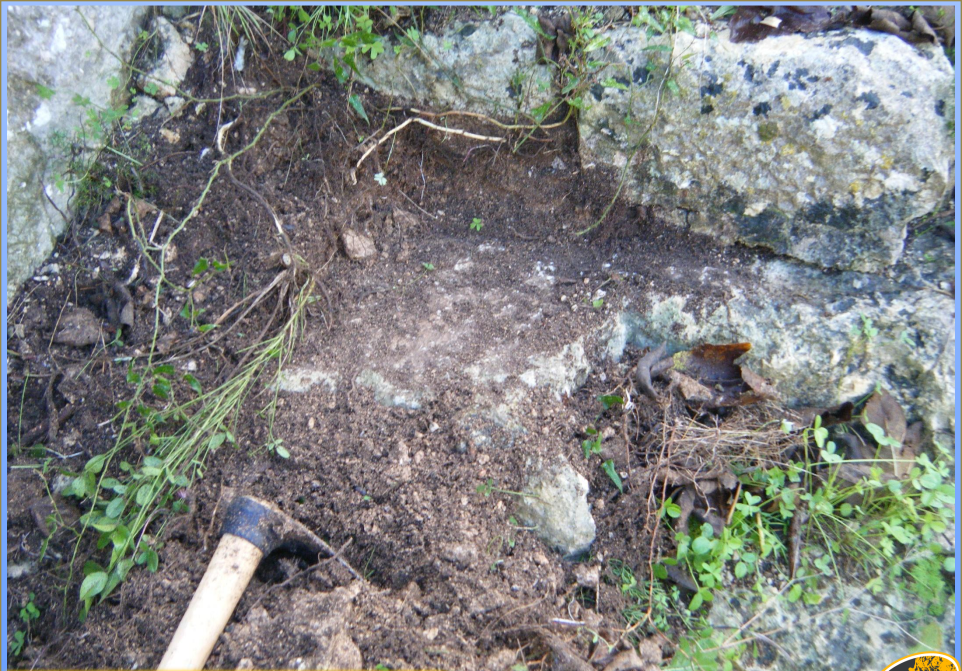
Wied il-Għasel Access Work
