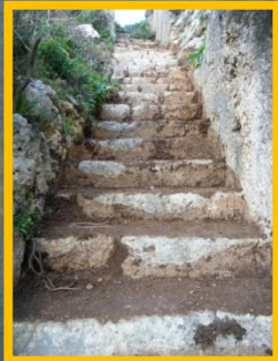
Wied il-Għasel Access Work
